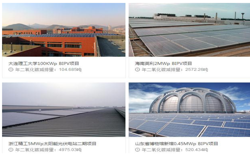
图表 27：中海阳太阳能光电一体化工程案例
