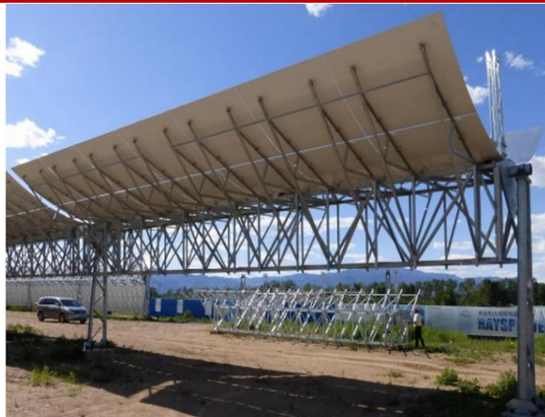
图表 5: 槽式集热器示意图
