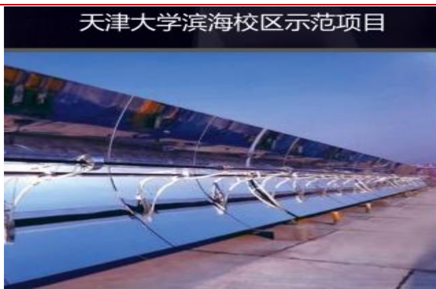
图表 30：中海阳太阳能光热示范项目
