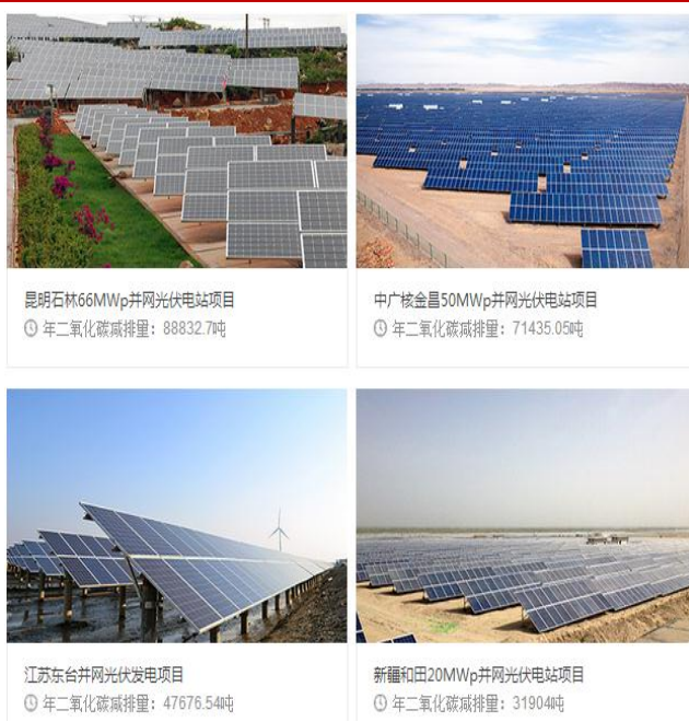
图表 26：中海阳太阳能并网光伏发电工程案例
